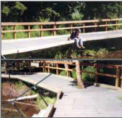
Pasarelas en el Río Russian
