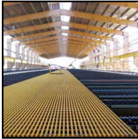
Instalación de minería de cobre
